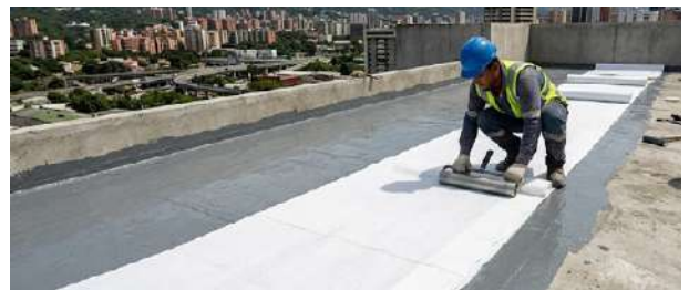
Impermeabilización en frío / Cold waterproofing
