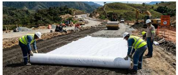
Construcción de carreteras / Road construction
